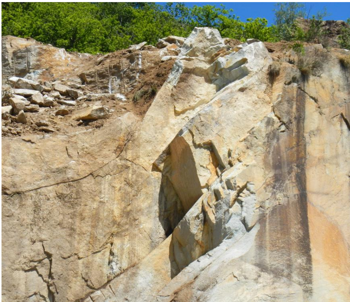
Foto 4-2. Particolare della “zona critica” con piani di pioda particolarmente acclivi.
