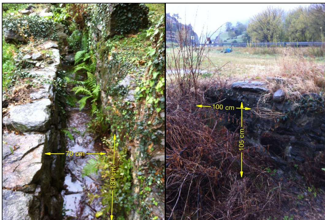
Foto 7-3. Sezioni della canalizzazione denominata 1 nella parte terminale, interessata dalle portate dell'intero bacino E. (A sinistra, tratto terminale del versante, poco prima del fondovalle; a destra, condotta che sottopassa la Strada Statale per confluire in Dora).
